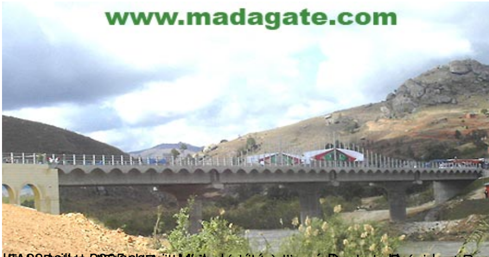
Le pont de Mahamasina, construit par l'Union Européenne, est un investissement du Président Ratsiraha à Mahamasina
